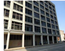
Bldg A - Lamar
